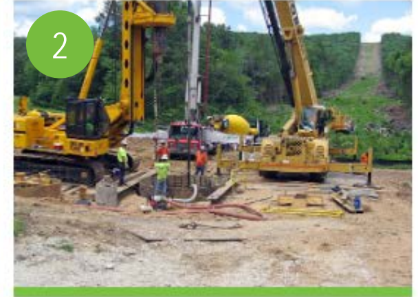
Auger holes and pour foundation
