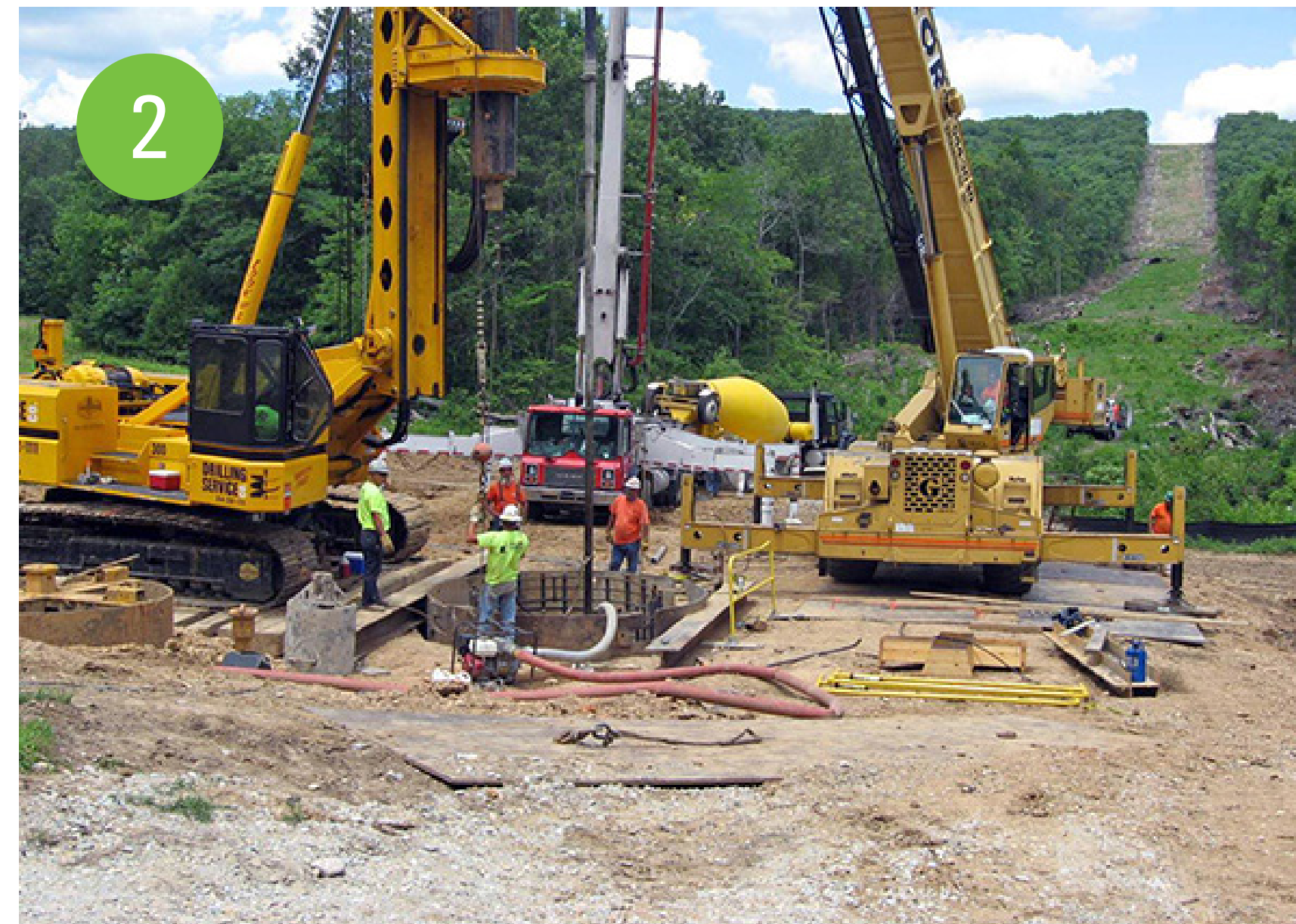
Auger holes and pour foundation
