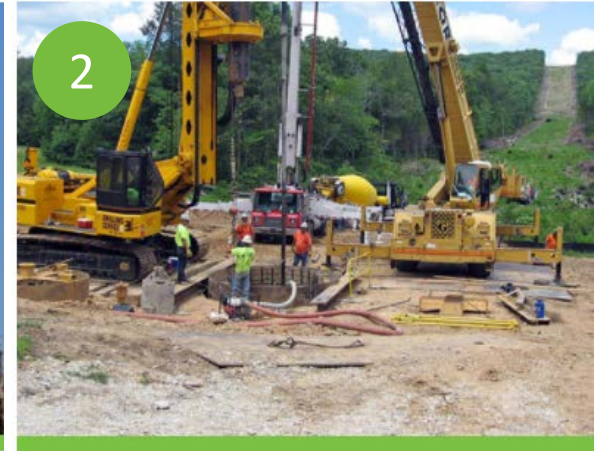
2 Auger holes and pour foundation
