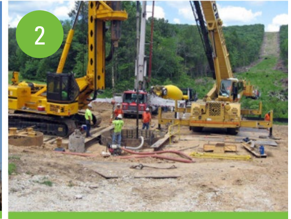
Auger holes and pour foundation
