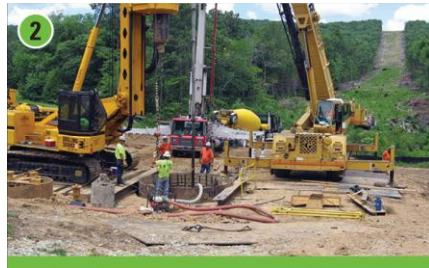
Drill hole and pour foundation
