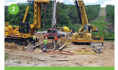
Drill hole and pour foundation
