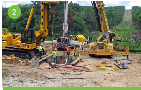
Auger holes and pour foundation
