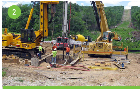
Auger holes and pour foundation
