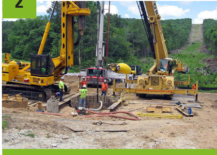
Auger holes and pour foundation
